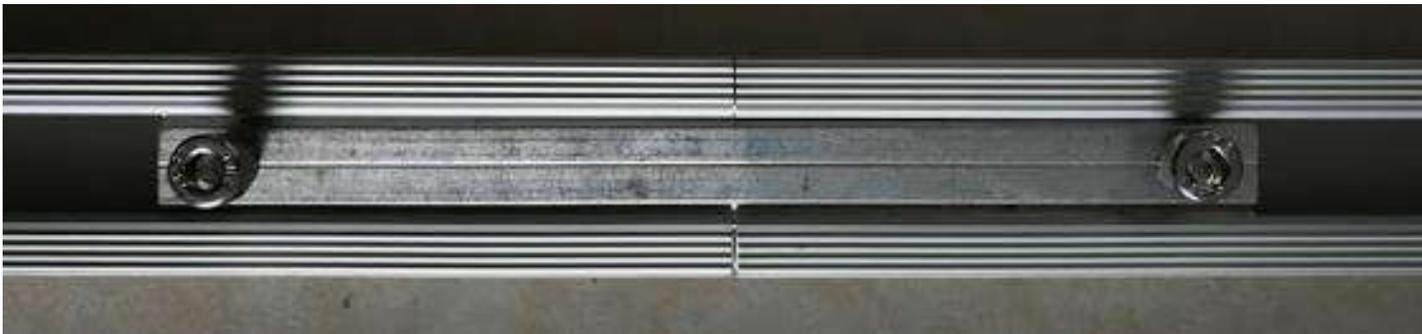
Una unión perfil por junta en la canal siguiente a la que recibe los paneles.
