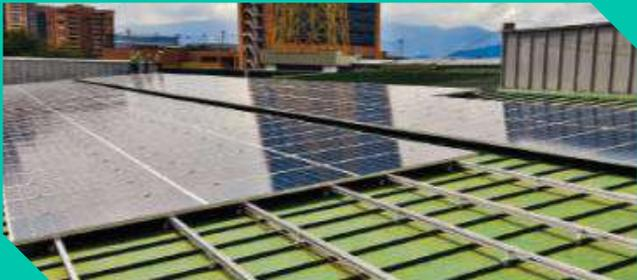
Está diseñado para el montaje de sistemas fotovoltaicos en los diferentes tipos de teja grafada más comunes del mercado, permite una fijación segura y rápida sin necesidad de perforaciones en las cubiertas.
